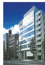
千代田テクノル 本社ビル
